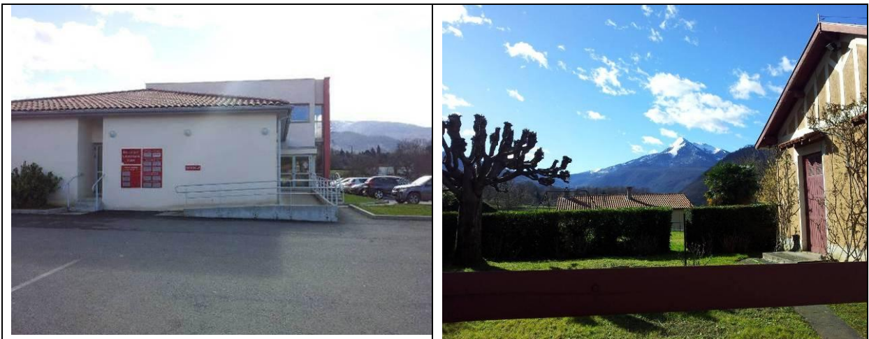
Figure 23 - La maison de santé d'Aspet (31) et le cabinet d'infirmières associées
