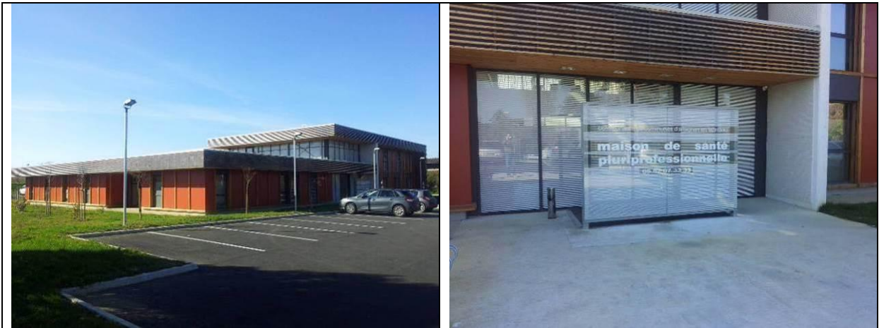
Figure 22 - La maison de santé de Vic-Fezensac (32)
