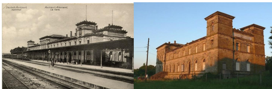
Figure 24. La gare d'Avicourt au-début du XXe siècle et son état actuel
