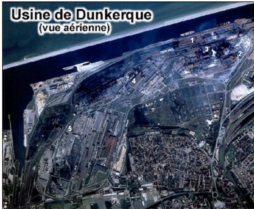
FIG. 1.9 – Vue aérienne du site sidérurgique Arcelor de Dunkerque. (1) quais à minerais, (2) chaînes d'agglomération des minerais, (3) hauts-fourneaux, (4) aciérie, (5) station de stockage des co-produits.
