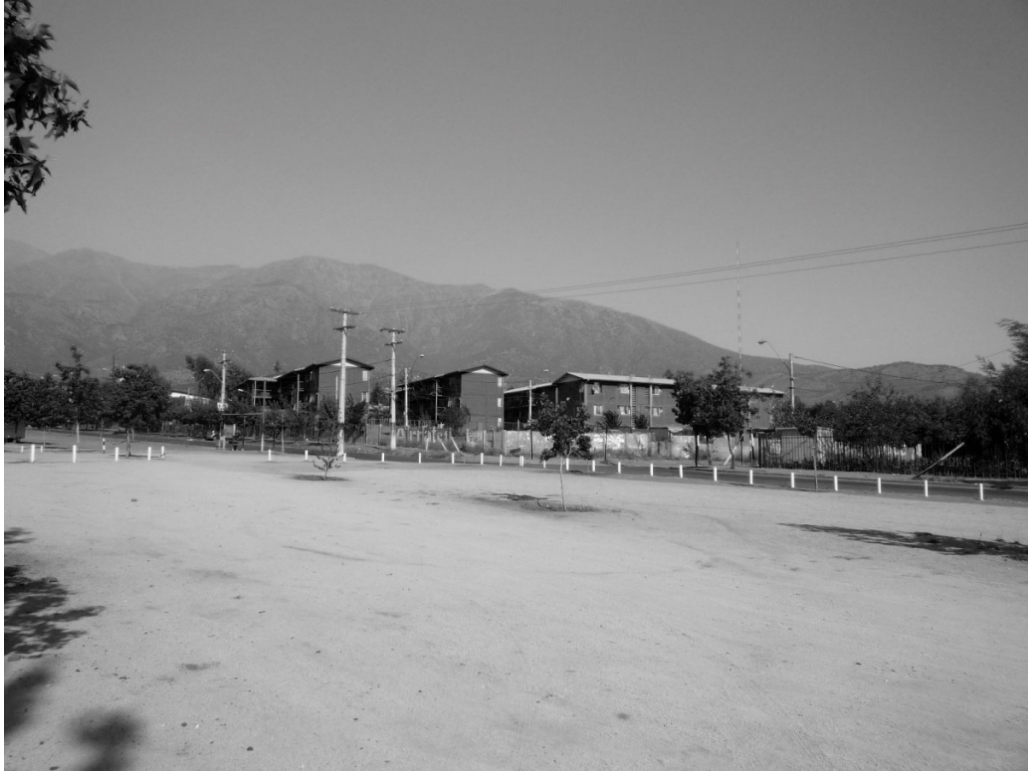
Fig. 3. Photographie des logements sociaux construits comme conséquence des coulées de boue de 1993. Source : photographie de l'auteur.
