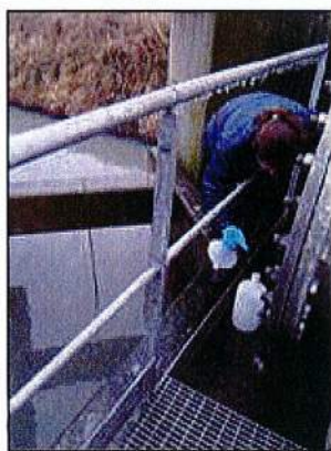
Figure 2. 17 : Emplacement du piège à sédiment installé à l'entrée de la station de relevage « Vallée de Scarpe ».
