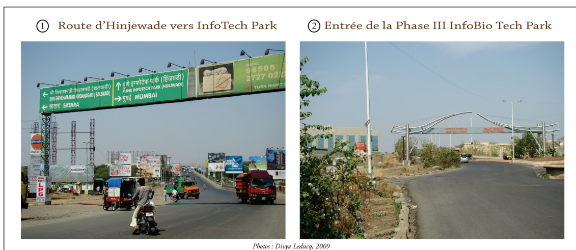
Photo 3.3 – Rajiv Gandhi Infotech Park, Hinjewade : état d'avancement des phases
