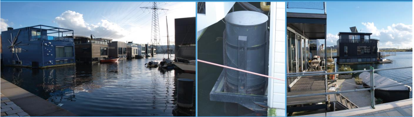
Photo 64 : vue des maisons flottantes à IJburg. Photo 65 : détail d'un pilier le long duquel glisse la plate-forme. Photo 66 : détail d'une maison flottante avec terrasse et «parking» à bateau. Source : S. Gueben-Venière, octobre 2013.
