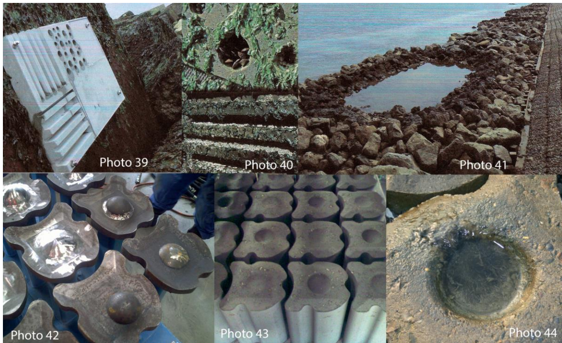
Photos 39 à 44 : éléments contribuant à la diversité des revêtements de digues. De gauche à droite et de haut en bas : (39) bloc d'éco-béton avant immersion, (40) bloc d'éco-béton après immersion, (41) retenue d'eau, (42) formes servant à modeler les colonnes de béton, (43) colonnes de béton prêtes à être utilisées, (44) colonisation par de micro-algues des petites cavités des colonnes de béton gardant une petite quantité d'eau de mer lorsque celle-ci se retire à marée basse. Source : Photos 39 à 41 : Deltares, 2010 ; Photos 42 à 44 : Y. Provoost, 2012.
