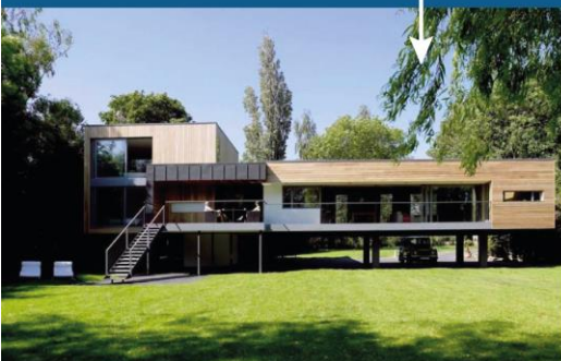
Photo 68 : maison reposant sur des piliers ancrés dans le sol. Source : J. Pardey, 2009
