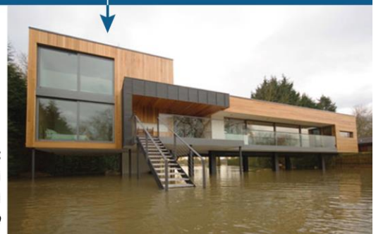
Photo 69 : la même maison en période d'inondation. Source : J. Pardey, 2009
