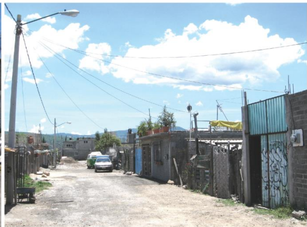
Photo 8.4. Tempiluli, Tláhuac, District Fédéral, 2011. Rue et logement (à droite) de Madame R., arrivée en 2005. Maison en construction en 2011 : murs en parpaings posés, salon-cuisine abrité par des bâches, salle de bain en tôles, et chambres en cours d'être couvertes par un toit en béton.
