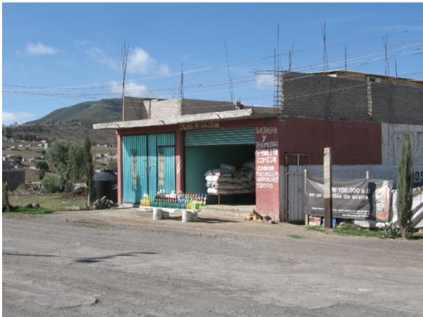
Photo 8.3. Lomas San Sebastián, La Paz, Etat de México, 2010. Logement, commerce et atelier agricole de Monsieur DS., arrivé en 2000. Construction sur un seul niveau en 2010, mais élévations prévue : murs en parpaings et chapes en béton. Murs de façade peints.
