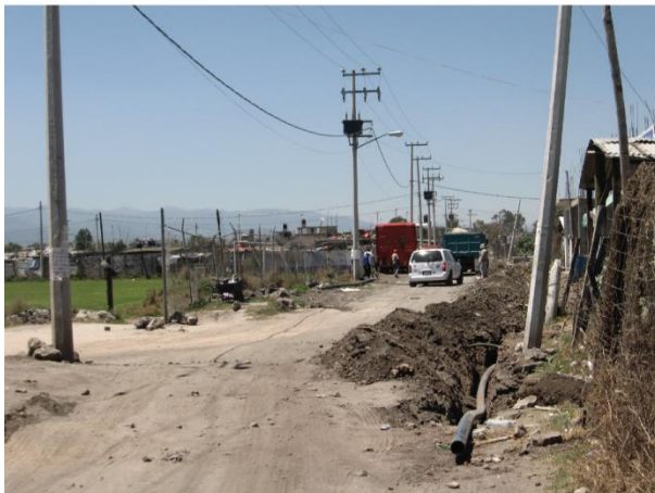
Photo 6.7. Tempiluli, Tláhuac, DF [2010] Pose de l'adduction d'eau, terrassements et électrification dans un quartier illégal
