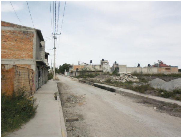
Photo 10.7. Travaux de construction des trottoirs, du réseau d'assainissement et de bitumage de la route à La Trinidad, Cuautitlán, Etat de Mexico [2011]
