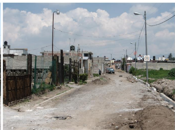
Photo 6.14. Santa María Ixtacalco, Cuautitlán, Etat de México [2011] Pose de l'adduction d'eau et des égouts et construction des trottoirs
