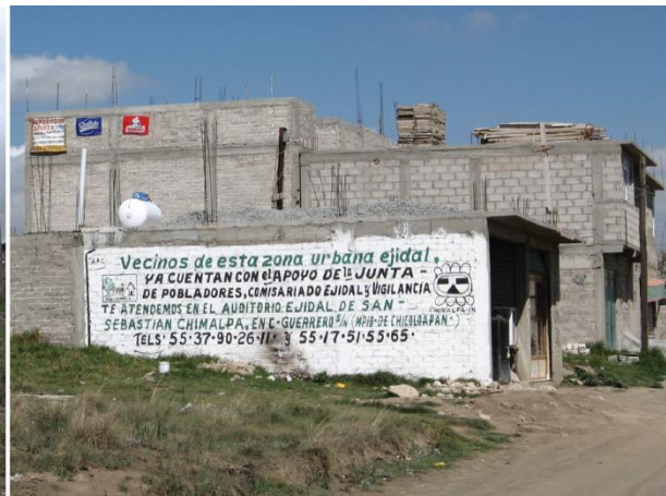
Photo 10.2. Affichage mural de la présence des autorités ejidales, Lomas San Sebastián, La Paz, Etat de México [2010] "Résidents de cette zone urbaine ejidal. Vous pouvez désormais compter avec le soutien et la surveillance du conseil des habitants et du commissaire ejidal. Nous tenons une permanence à l'auditorium ejidal de San Sebastián Chimalpa, Colonie Guerrero, municipio de Chicoloapan"
