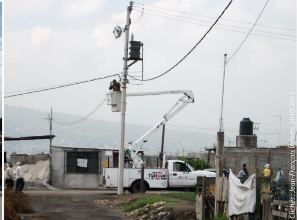
Photo 10.10. Travaux d'électrification à Tempiluli, Tláhuac, DF [2010] Camion de la délégation pour la pose des câbles légaux : frais et matériel partagés entre la municipalité et les résidents
