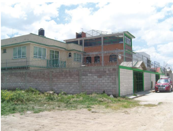
Photo 8.9. Tlaxculpas, Cuautitlán, Etat de México, 2011. Très grande maison récente (2009) d'un propriétaire originaire du DF. Construction achevée de 3 niveaux en matériaux de qualité, et efforts de protection de l'extérieur (murs élevés et 3 niveaux de barbelés)
