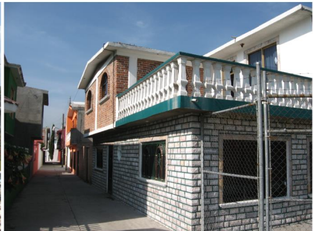
Photo 8.8. Tlaltepán, Cuautitlán, Etat de México, 2011. Maison de la famille R., originaire du village. Maison de naissance du chef de famille (1968). En 2011, construction achevée sur 2 niveaux en dur, plusieurs chambres et salons, éléments de décoration témoignant de l'ancienneté de la préoccupation esthétique pour le logement.
