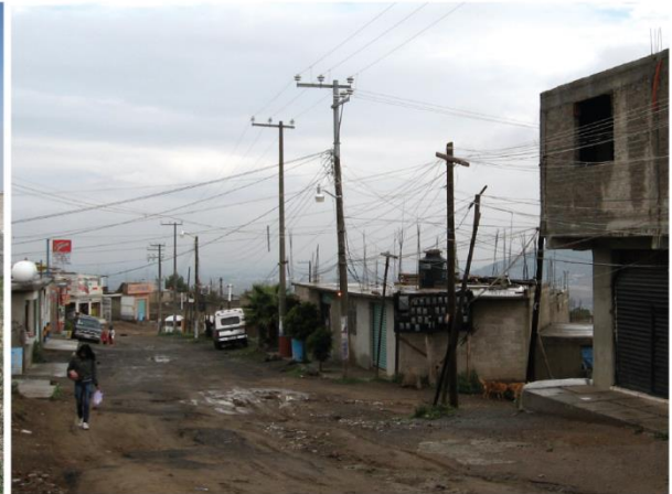
Photo 6.12. Lomas San Sebastián, La Paz, Etat de México [2010] Co-présence des réseaux électriques "pirates" et légaux
