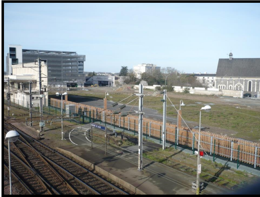
Photo 4 - Le site de Gare + : au fond, le nouveau parking public (février 2014) 111
