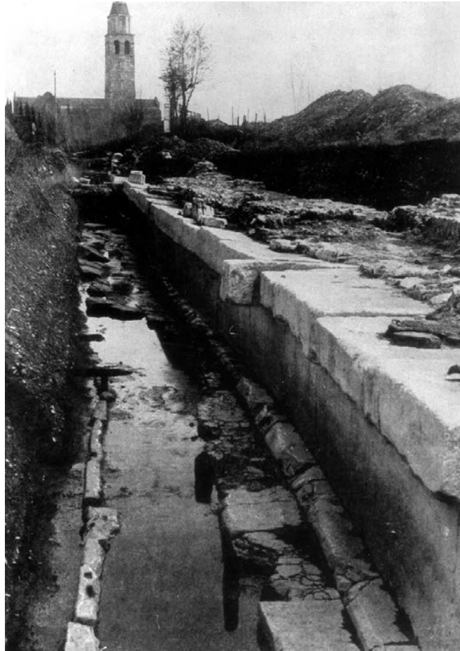
Figure 7.18 – Portion de quai découverte sur le site du port fluvial romain d'Aquilée [d'après Arnaud-Fassetta et al. , 2003]. La structure délimite la rive droite du paléochenal du fleuve Natissa (cliché G. Brusin, 1934).
