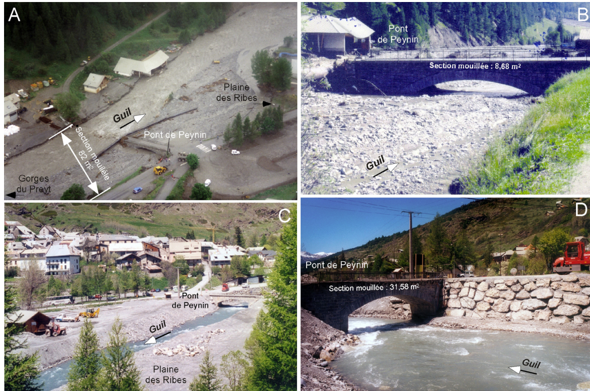
Figure 8.17 – Le Pont de Peynin à Aiguilles pendant et après la crue de juin 2000 [d'après Arnaud-Fassetta et al. , 2005]. A : 13 juin 2000. Vue aérienne oblique montrant le Pont de Peynin partiellement remblayé et la défluviation du Guil sur la rive gauche ; la section mouillée du chenal est de 82 m 2 (cliché RTM, 2000). B : 14 juin 2000. Détail du Pont de Peynin remblayé aux trois quarts par les alluvions du Guil avant la défluviation ; la section mouillée sous le pont est réduite à 8,68 m 2 (cliché PNRQ, 2000). C : Juillet 2000. L'ancien chenal du Guil a été restauré (creusement à la pelle mécanique) ; ses déblais graveleux servent à la construction de merlons sur les deux rives et au remblaiement artificiel du chenal de défluviation située dans une zone d'activités (cliché M. Fort, 2000). D : Mai 2002. Le creusement à la pelle mécanique du chenal du Guil a provoqué un phénomène d'érosion régressive qui affecte les piles du pont. Des enrochements de berge ont été construits pour protéger la rive droite et l'hôpital d'Aiguilles en aval alors que la rive gauche n'a pas été équipée (cliché G. Arnaud-Fassetta, 2002).
