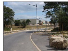
Photo n°2 : Vue du projet (2012)
