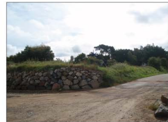
Photo n°2 : Vue au nord-ouest de la parcelle
