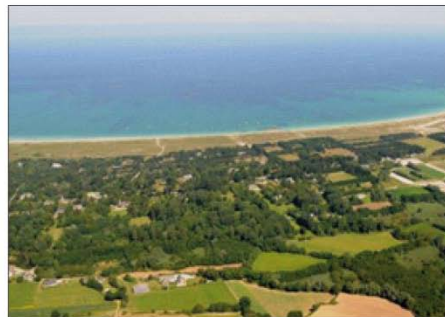
Photo n°1 : Vue aérienne de Keremma-Kerjane (Source : E. Le Cornec, GEOS, 08/08/2012)
