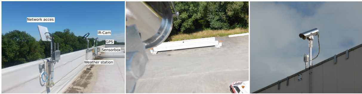
FIGURE 7.13 – Site d'essai de l'IFSTTAR
