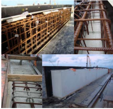
FIGURE 7.5 – Fabrication des poutres sur chantier
