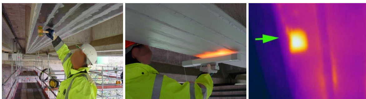
FIGURE 1.7 – Sondage acoustique et contraste thermique - Crédit images LRPC Autun France
