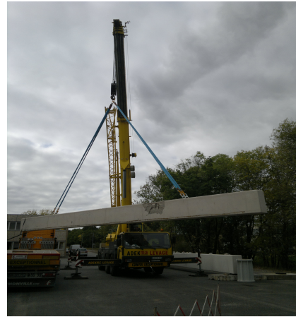
FIGURE 7.11 – Mise en place des poutres sur le site de l'IFSTTAR Bougenais
