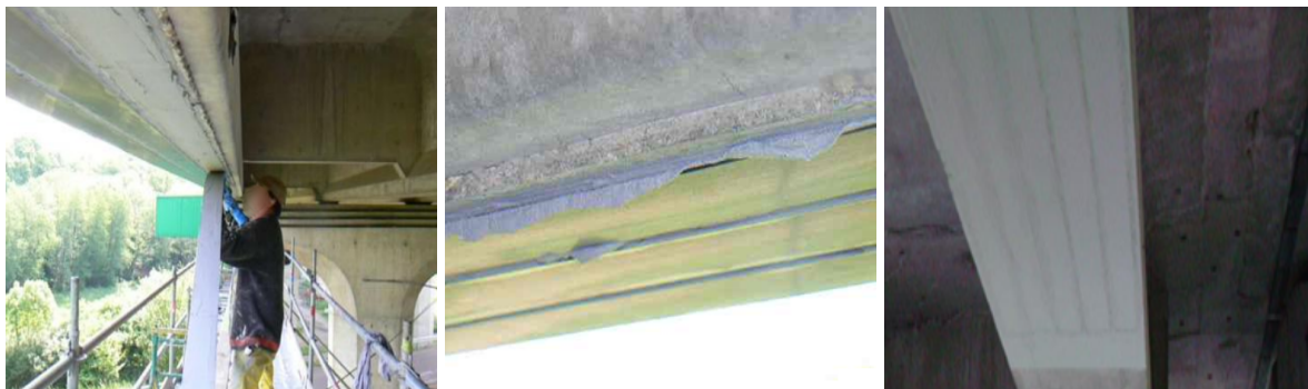
FIGURE 1.6 – Collage du composite, vue en détail de la colle et aspect final - Crédit LRPC Autun France
