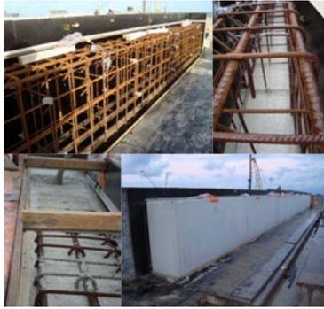
FIGURE 7.5 – Fabrication des poutres sur chantier
