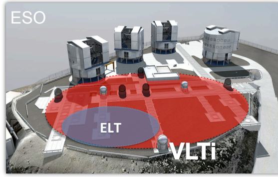
FIGURE 2.1 – Le Cerro Paranal avec les 4 télescopes unitaires de 8m de diamètres et les 4 télescopes auxiliaires de 1.8m. En bleu, la taille du miroir primaire de l'ELT. En rouge : la taille du télescope synthétisé par interférométrie avec les 4 télescopes auxiliaires.
