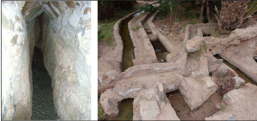
Photographie 10: Foggara et seguia du réseau d'irrigation de Figuig (Source : Janty, 2011)
