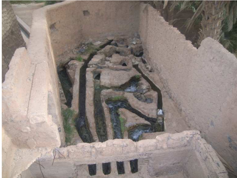
Photographie 12 : Le répartiteur principal de la source Tzaddert à Zenaga (Janty, 2010)
