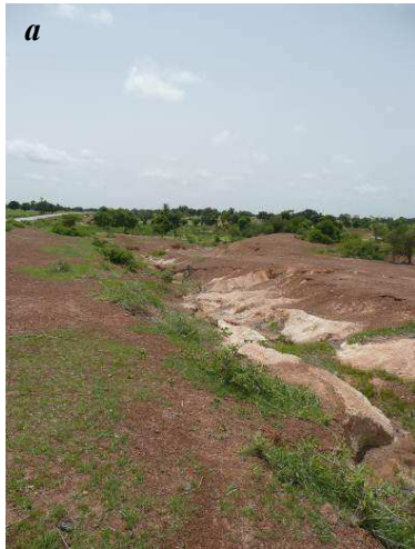
a : Ravine côté droit de la RN 16 Différenciation de couleur : roche en place, secteur érodé et sables
