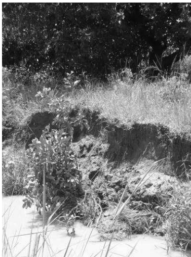
Photo 53 : Erosion des berges à Zaba
