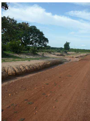
b : Bordure de fossé présentant des rigoles
