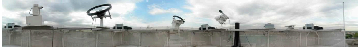
Figure II-15 : Vue panoramique des instruments de la station IDMP de Vaulx-en-Velin, durant l'année 2005
