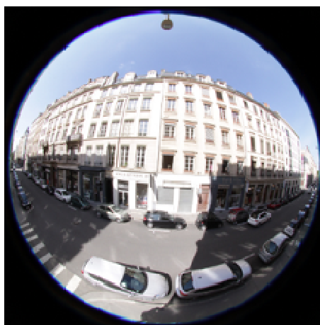
Figure IV-66 : Photo correspondant à la série de mesures de la façade Ouest à 50 m
