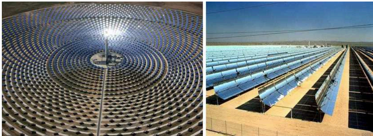
Figure I-10 : Centrales solaires thermodynamiques à concentration à tour (à gauche) et à miroirs cylindro-paraboliques (à droite)
