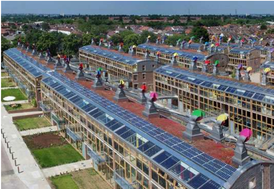
Figure I-6 : Vue des façades sud de l'écoquartier BedZED
