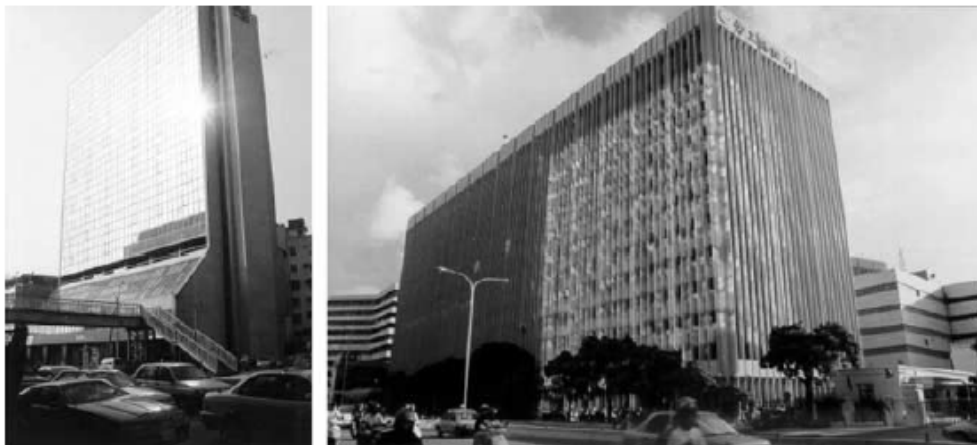
Figure II-21 : Bâtiment émettant une lumière éblouissante (à gauche) et bâtiment en subissant les effets (à droite) (Shih et Huang, 2001)
