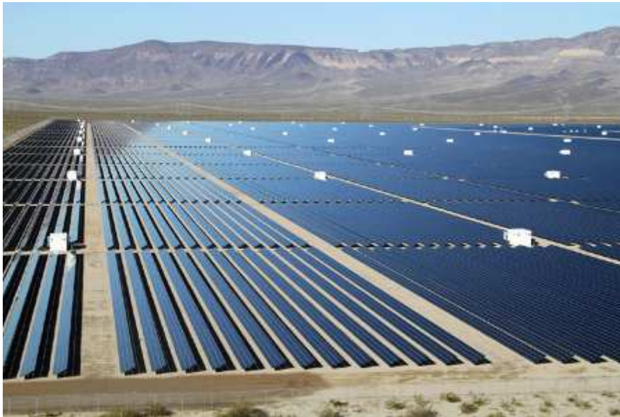
Figure I-12 : Centrale PV "Copper Mountain Solar Facility" dans le Nevada (150 MWc)
