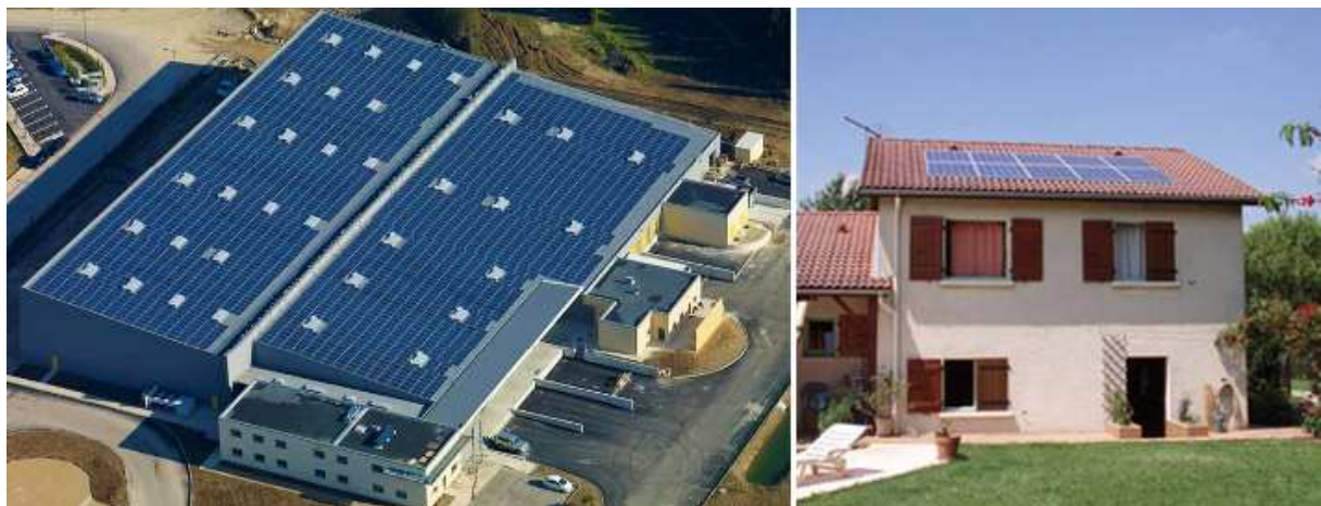
Figure I-13 : Centrale PV en toiture de 694 kWc sur un entrepôt (à gauche) et sur le toit d'un particulier avec 2 kWc (à droite)
