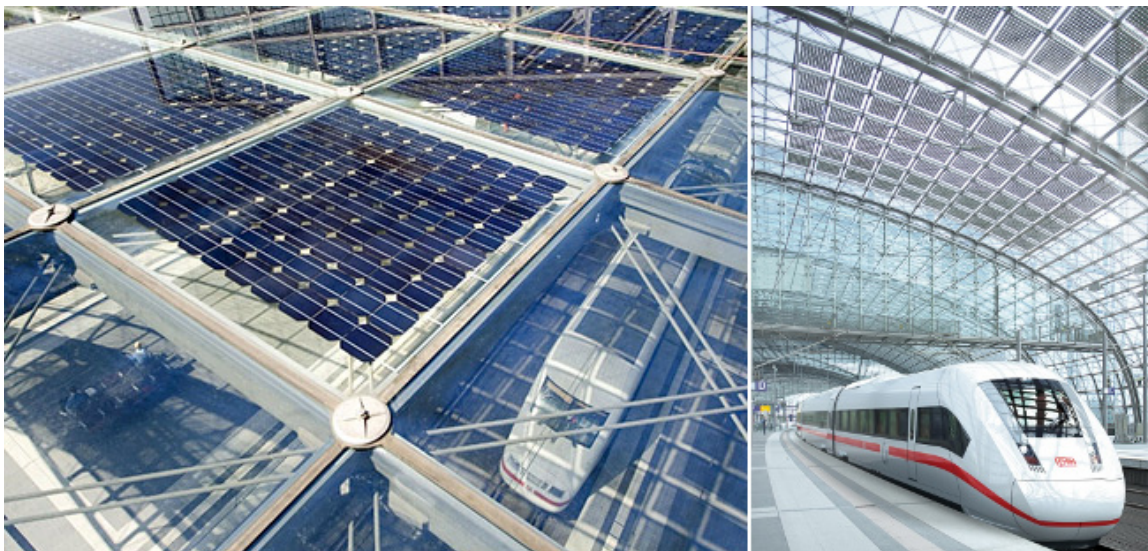
Figure I-14 : Intégration de cellules PV dans une structure transparente, dans la gare principale de Berlin
