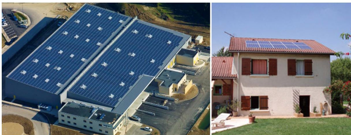
Figure I-13 : Centrale PV en toiture de 694 kWc sur un entrepôt (à gauche) et sur le toit d'un particulier avec 2 kWc (à droite)
