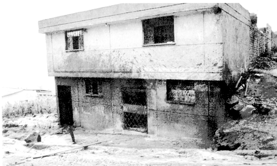
Photo 2 : Traces laissées par le passage de la lave torrentielle sur l'une des maisons du quartier
