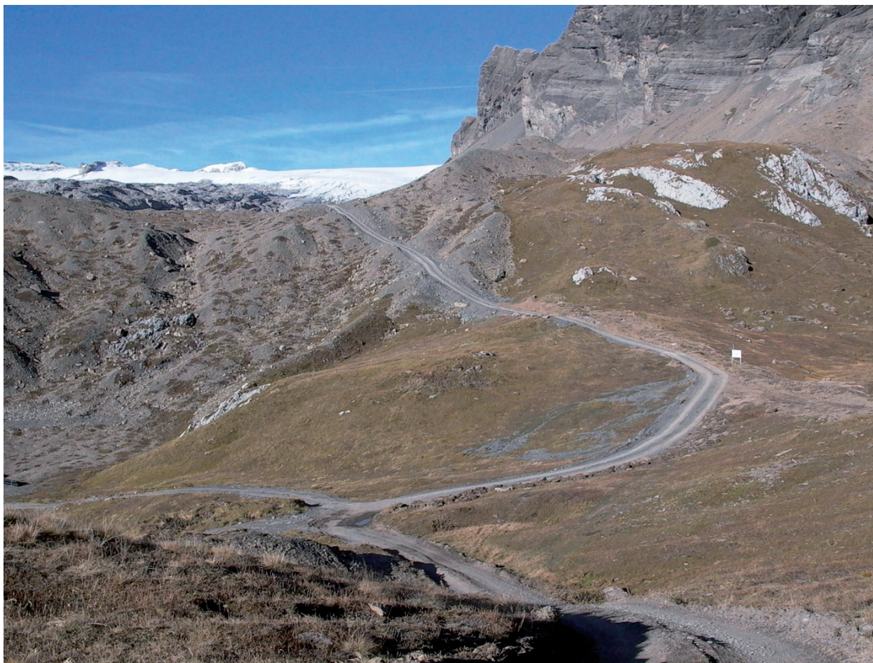
Figure 9 - Route tracée dans la marge proglaciaire de Tsanfleuron pour l'installation d'une adduction pour l'enneigement artificiel du domaine skiable de Gstaad 3000 (Photo : E. Reynard, octobre 2006). Cette route a maintenant été détruite et le terrain plus ou moins remis en état.
