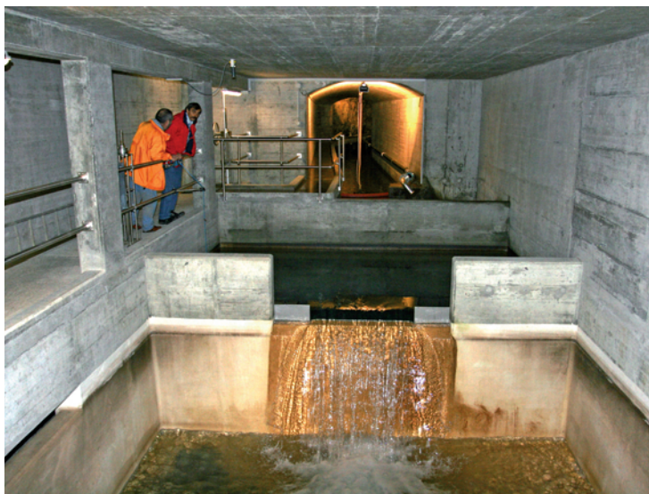
Figure 2 - Captage de la source de Glarey exploitée pour l'alimentation en eau potable de la commune de Conthey (Photo G. Favre).
