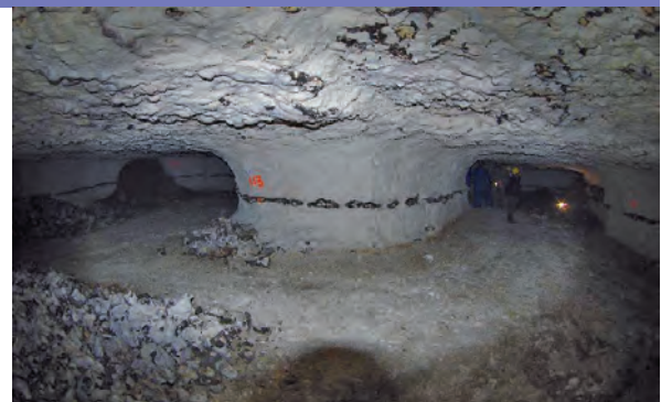
Figure 13 - Marnière de Saint-Nicolas de la Taille (Seine Maritime) modélisée à partir de 350 photos acquises au fish-eye et utilisation du flash : extrait du modèle 3D et une des photos.
