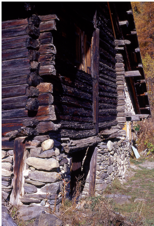
Figure 6 - Grange traditionnelle en mélèze, caractérisée par la technique d'empilage des bois (« blockbau ») dans la vallée de la Clarée, Briançonnais (photo JLE).
