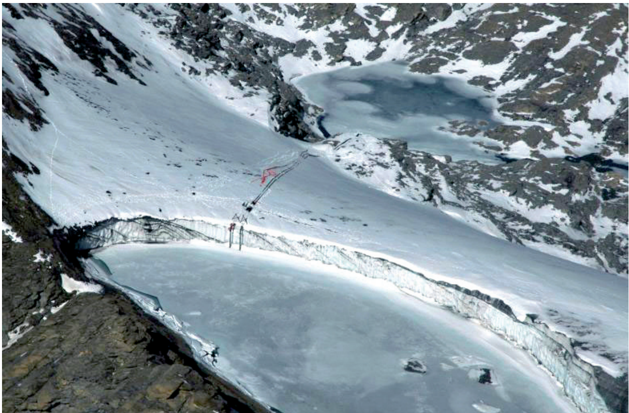
Figure 2 - Le lac juxtaglaciaire de Rochemelon. Noter le système artificiel de vidange destiné à enrayer la menace de rupture brutale (photo : M. Caplain, 10/2004).
