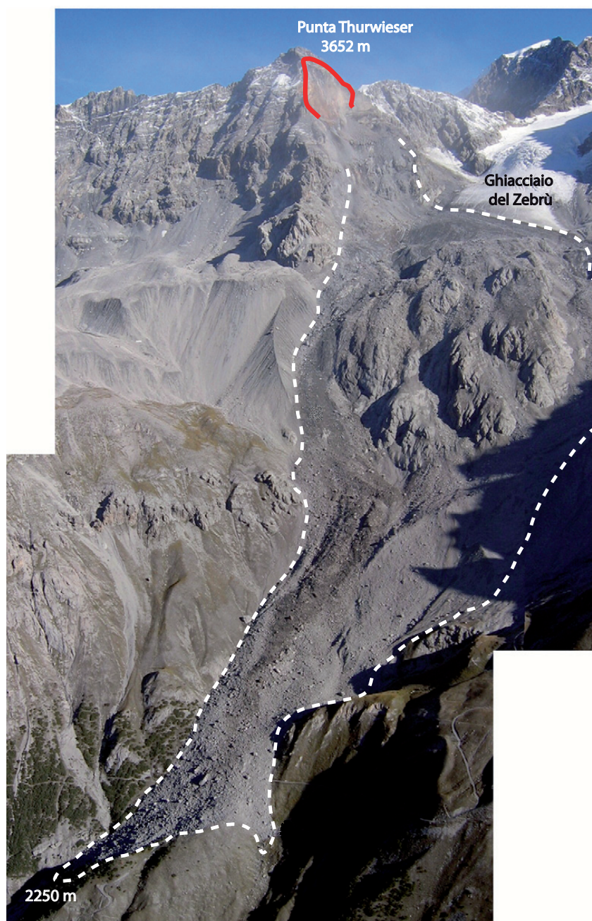
Figure 4 - Niche d'arrachement (en rouge), parcours et dépôt (tireté) de l'écroulement de 2004 à la Punta Thurwieser (photo : D. Fossati).
