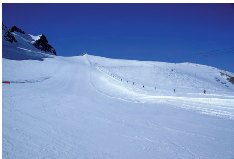
Photos 4 et 5 - Téléskis des Trifides et de la Girose (La Grave) : le déplacement rapide du glacier oblige à amarrer les remontées mécaniques aux parois rocheuses et à ne disposer que de pylônes « mobiles » à la surface du glacier. On distingue également les zones de crevasses signalées comme dangereuses sur les pistes de ski et partiellement rebouchées par le service des pistes. © B. Feuillet, 17 mars 2007.
