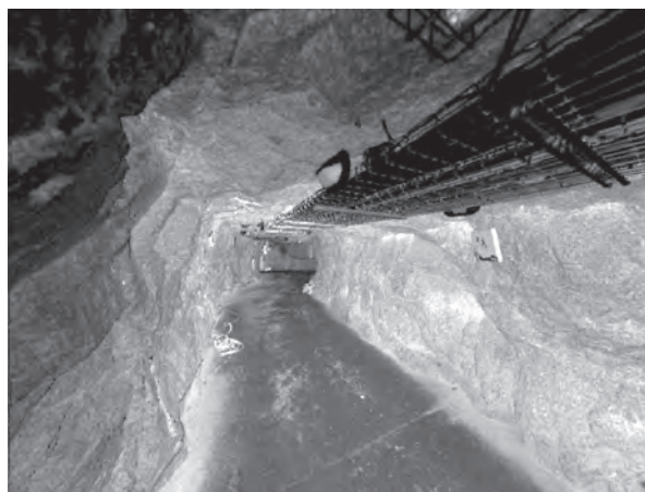
Figure 5 - Nuage de points dans la galerie « Vallée Blanche » du Piton nord de l'Aiguille du Midi, acquis par laserscanning courte portée.
