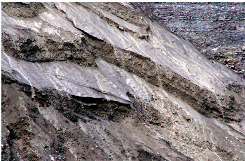
Figure 11 - Dépôts de pente érodés exposant un permafrost à ciment de glace (couches de glace issues du recouvrement des chutes de neige hivernales), à 2400 m d'altitude en aval de la cicatrice de l'éroulement de 2005 des Dents Blanches, Valais (photo B. Rey-Bellet).
