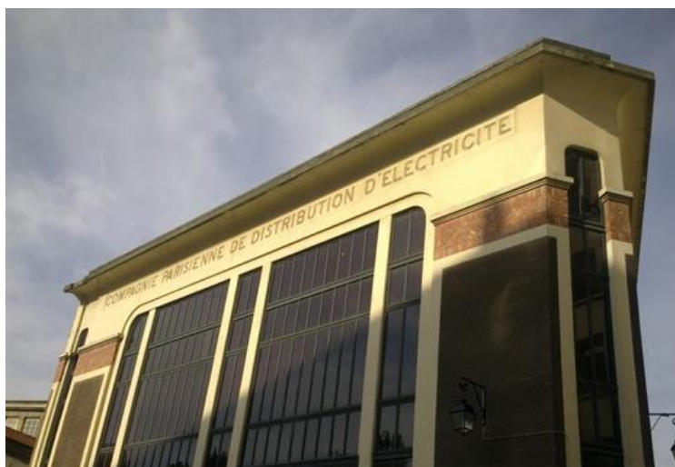
Ancien bâtiment de la Compagnie parisienne de distribution d'électricité situé dans le X ème arrondissement de Paris.
