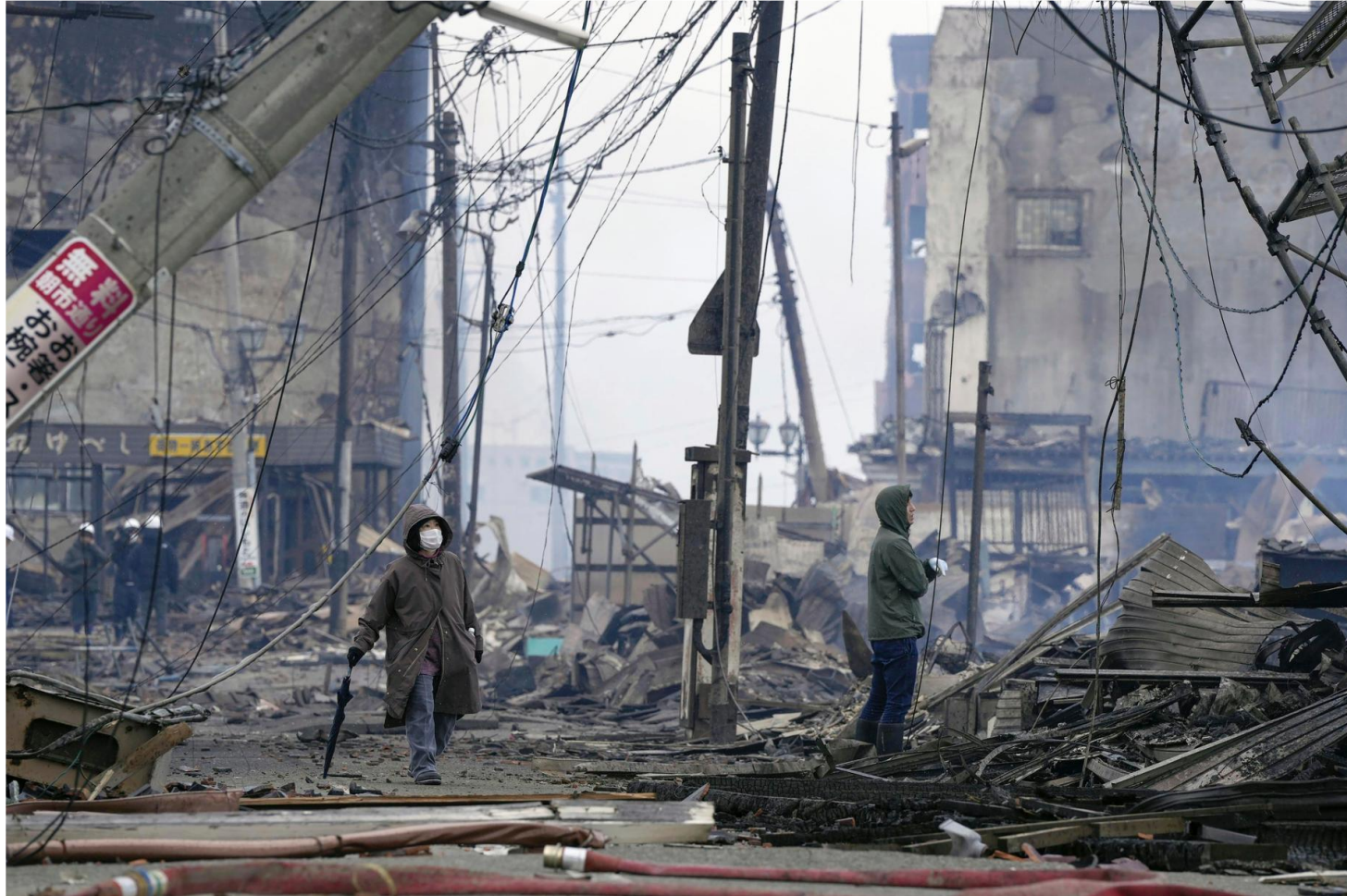
Rupture des réseaux Le Monde (06/01/2024) Péninsule de Noto, Japon
