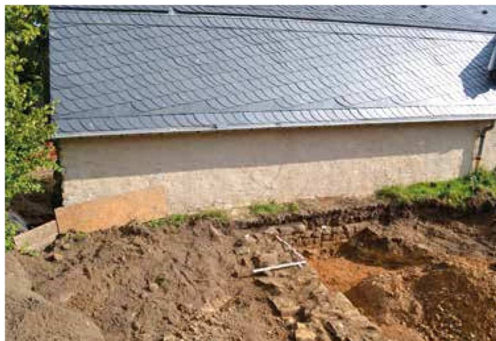
Fig. 5 : Vue vers l'est du décapage de la terrasse située entre la poudrière à l'ouest et les écuries (ici vue de sa façade ouest restaurée), ayant permis la mise au jour des vestiges médiévaux et des remblais contenant des fragments lapidaires antiques (Cl. : J.-D. Laffite, Inrap).
