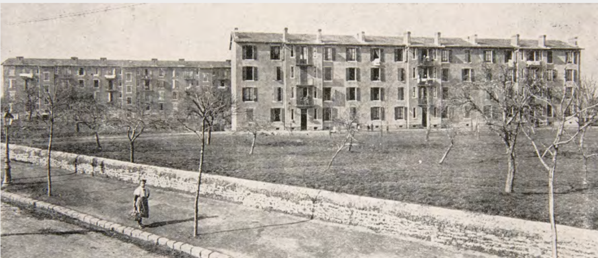
Fig. 7. Logements ouvriers. Deux bâtiments semblables, avenue de la République, entre Clermont et Monferrand, 1917.
