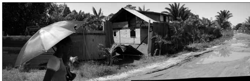
● Figure 7. – Sablance, maison en construction, 2009. Photographie F. Piantoni.
