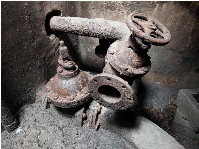
Figure 23 : le bassin de Pierre-à-Chaux en 1873 (AM Montbrison 4 w 95 et 96) et sa tuyauterie encore en place de nos jours (cliché C. Mathevoit).
