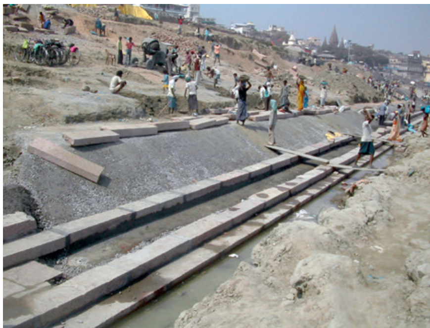
Fig. 3. Construction d'un ghāt en amont d'Assi ghāt , février 2008. (clichés Savitri Jalais)
