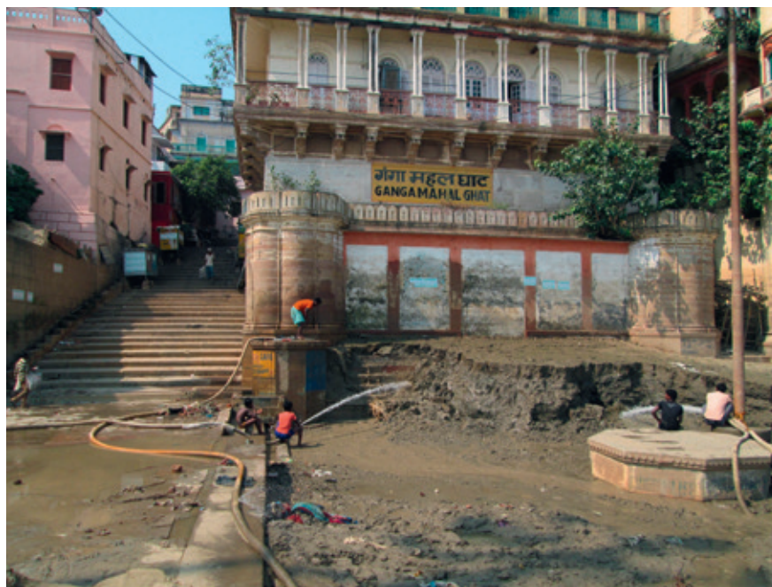
Fig. 6. Nettoyage d'un ghāt pendant la période des inondations, octobre 2010.
