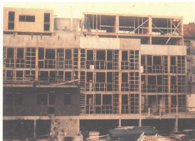
FÉVRIER 1982 La façade cour du bâtiment principal. Ossature de façade en bois sur planchers béton. Le parement en ardoises de fibrociment est en cours de pose. Les dormants des fenêtres sont posés. En attique, à gauche les duplex sont en train d'être bardés. A droite la structure est en place, l'ossature de façade est en cours.
