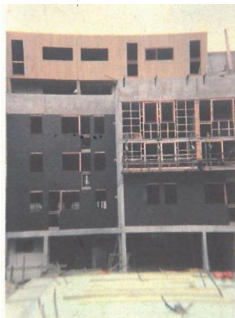
FÉVRIER 1982 La façade cour du bâtiment principal. Au premier plan: la dalle béton des duplex sur cour.
