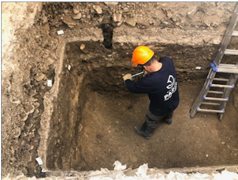
Fig. 4 : Test à la tarière manuelle. Photo : L. Sabardine, DHAAP.
