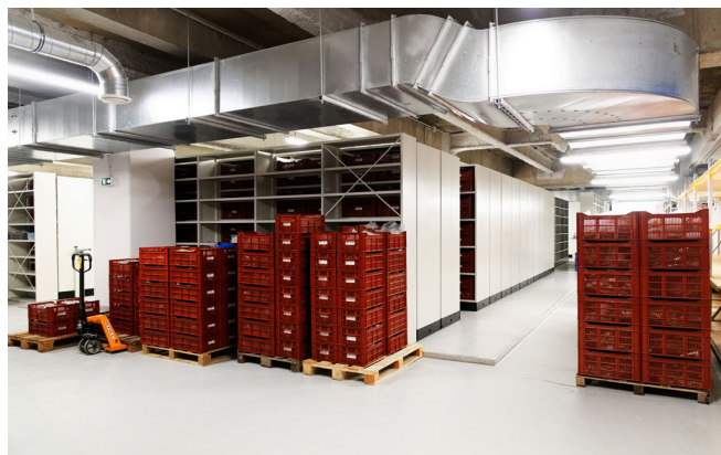
Fig. 6 : salle de stockage du DHHAP rue du Pré
