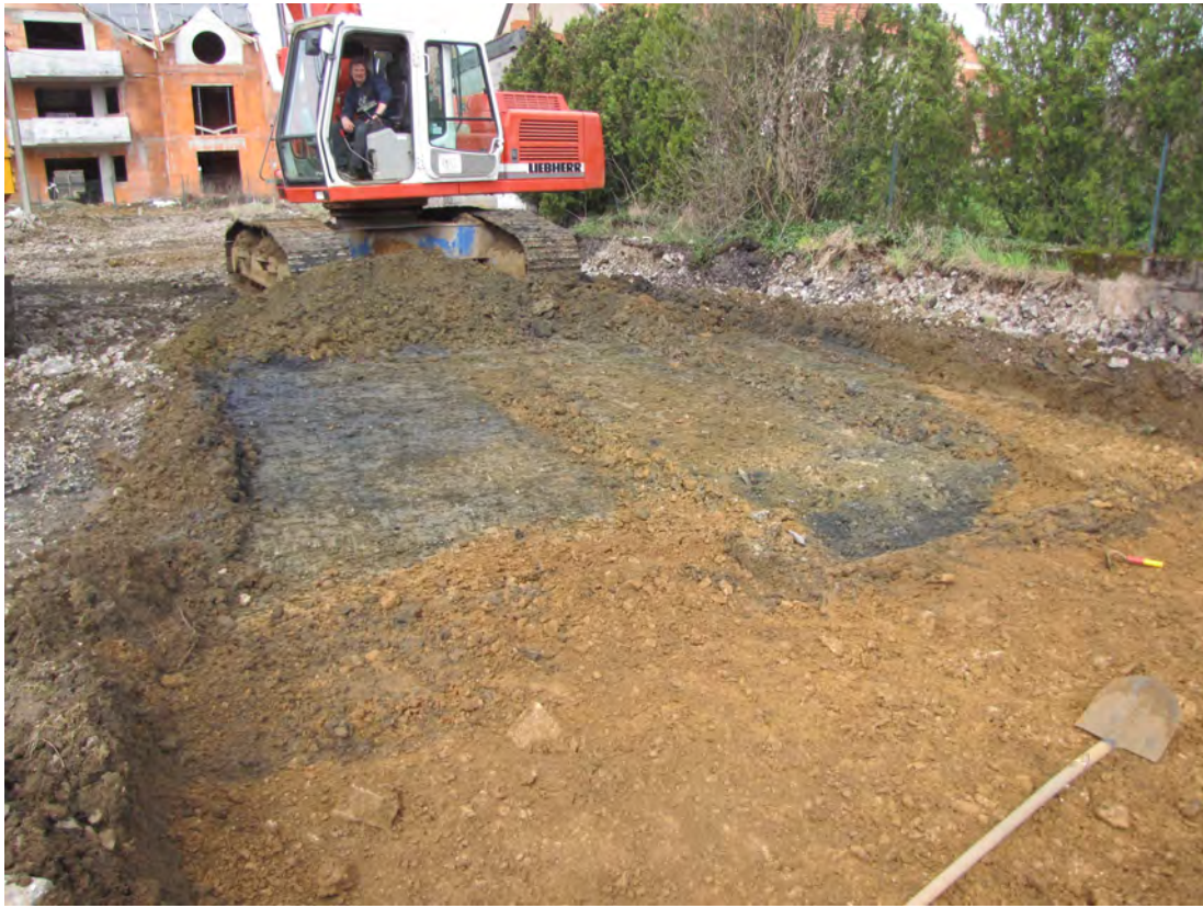
Figure 017 – Décapage de la zone polluée
