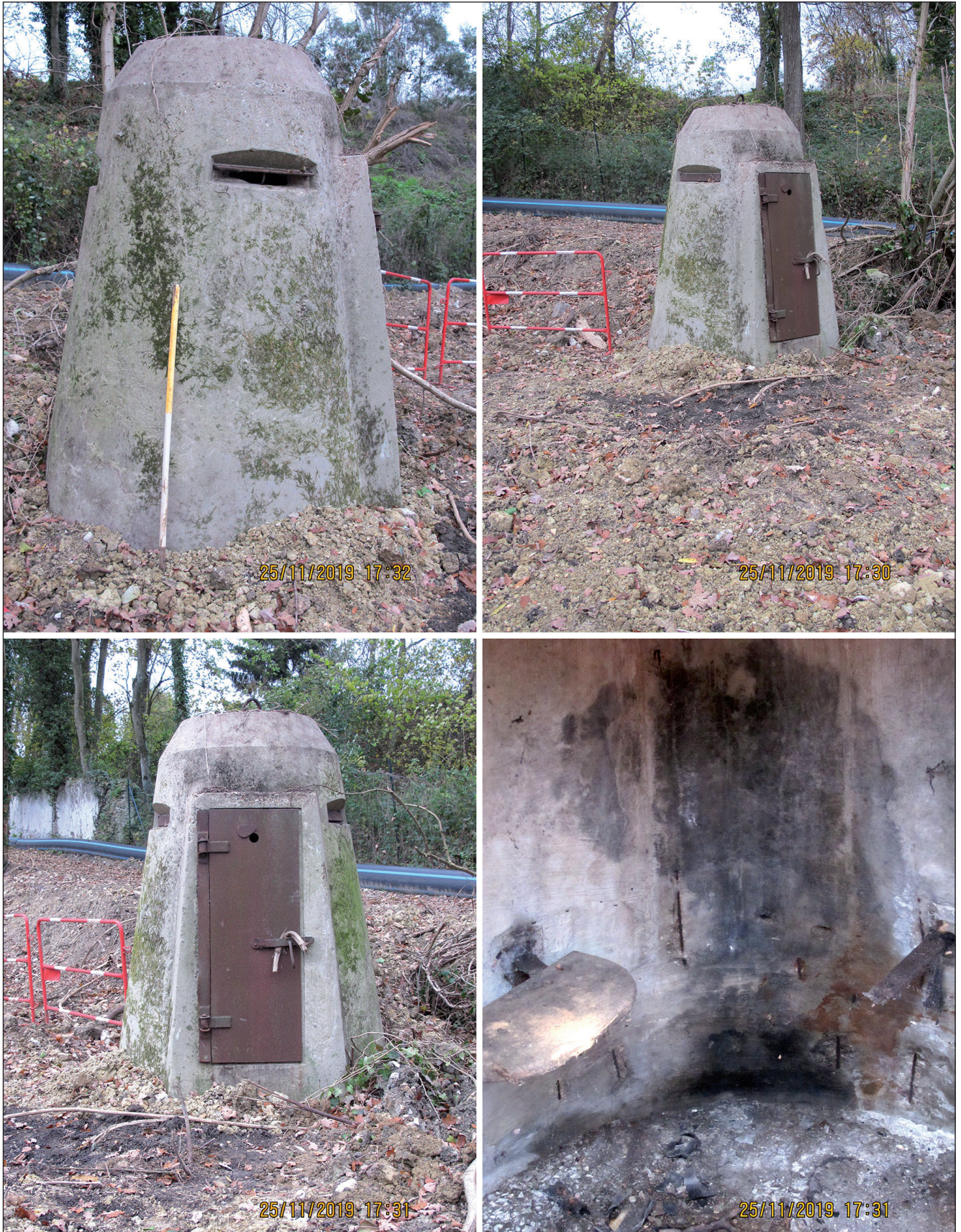
Fig. 106 Planche des clichés de terrain du dispositif de protection, N. Paccard, Inrap
