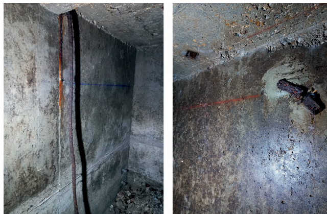
Fig. 60 Système d'éclairage. Clichés Cristina Gonçalves-Buissart, BPA.
