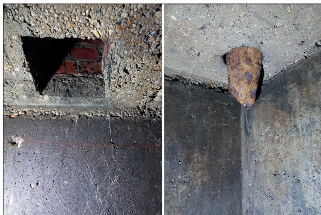
Fig. 58 Exemple de rigole et de puisard d'évacuation. Clichés Cristina Gonçalves-Buissart, BPA.
