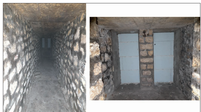
Fig. 54 Vues du couloir d'accès au groupe scolaire Jean Jaurès. Clichés SémoFi.
