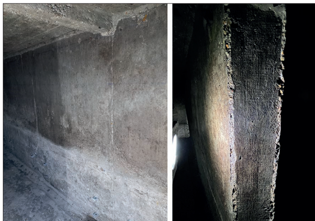
Fig. 56 Exemple d'une tranchée-abri avec tracé « en grecque », en béton avec dalles préfabriquées. On distingue les limites des dalles (à gauche). La vue de droite montre l'épaisseur des dalles. Clichés Cristina Gonçalves-Buissart, BPA (à gauche) et Nicolas Girault, SRAIF (à droite).
