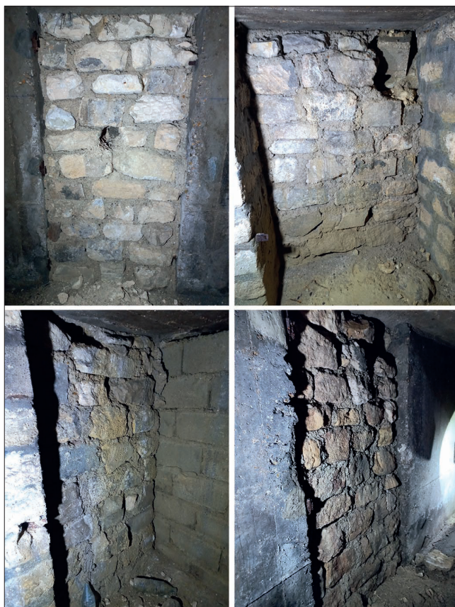
Fig. 57 Exemple de murs maçonnés condamnant des accès ou tronçons de galerie. Clichés Cristina Gonçalves-Buissart, BPA.
