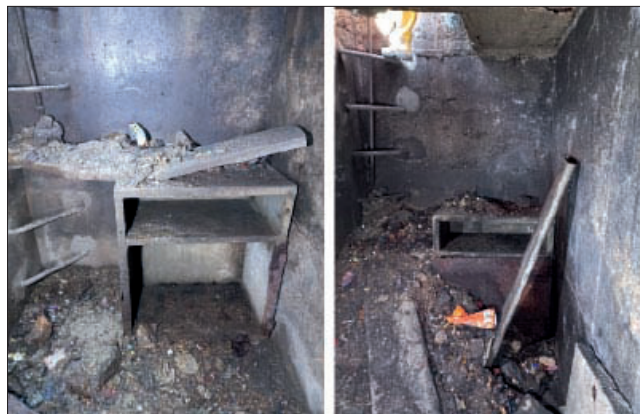
Fig. 62 Meubles de rangement ou de stockage. Clichés Cristina Gonçalves-Buissart, BPA.
