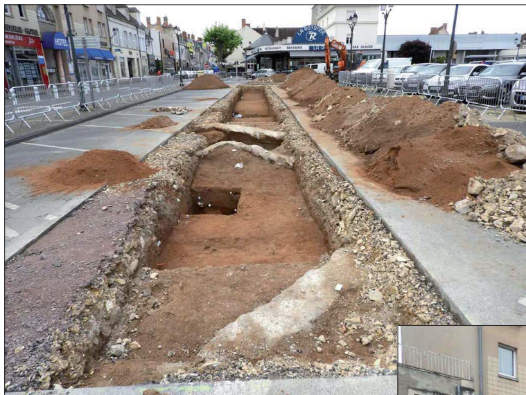
Fig. 101 La tranchée bétonnée.
