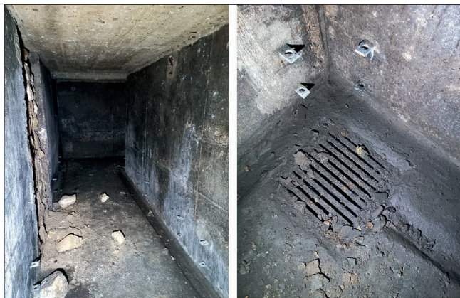
Fig. 59 Exemple de trous de ventilation et d'aération. Clichés Cristina Gonçalves-Buissart, BPA.
