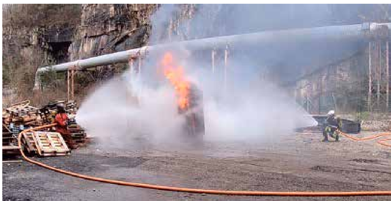
Figure 57: Action de deux lances à débit variable à 500l/min chacune sur une armoire de batterie de 40kWh.
