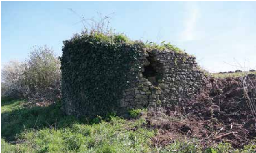
Figure 14 – Vue depuis l'ouest de la construction semi-circulaire et d'éléments de maçonnerie récemment détruits (cl. J. Remy, mars 2021)
