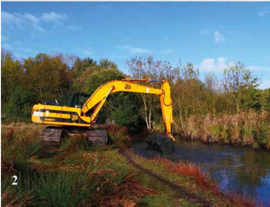
Figure 16 – (1) : curage en cours d'un canal le long de l'île Pendille en Saint-Joachim (cl. J. Remy, novembre 2021) ; (2) : curage d'un canal dans le bassin aval des marais de Goulaine, au nord du château de Goulaine (cl. J. Remy, octobre 2021)
