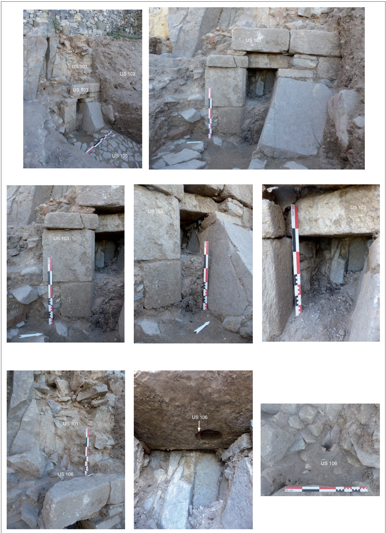
Fig. 21 Photographies de l'évacuation US103 et de la canalisation US106 de la tranchée 2 (© Aude Valérien, INRAP)
