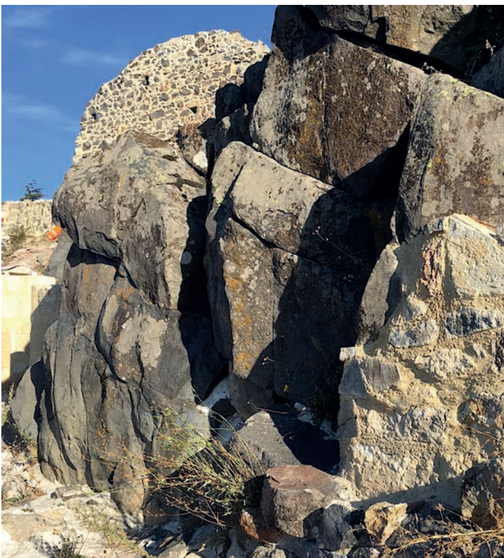
Fig. 7 Blocs de basaltes (dyke miocène) à la base des constructions. Surface altérée et diaclasée d'un bloc de basalte (© G. Vernet, INRAP).
