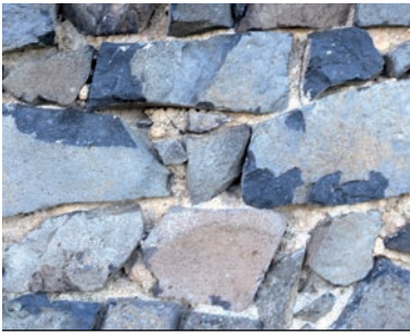
Fig. 8 Parement réalisé en blocs de basalte sommairement équarris (© G. Vernet, INRAP).
