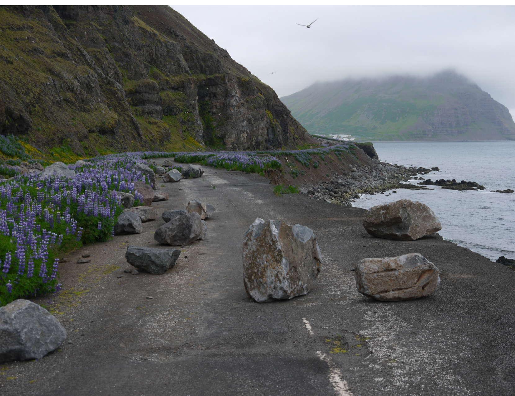
La route d'Óshlíð est fermée depuis 2010 du fait d'éboulements rocheux. Les mesures Schmidt sur ces blocs sont donc associées à cette date. (© E. Portier, 2022)
