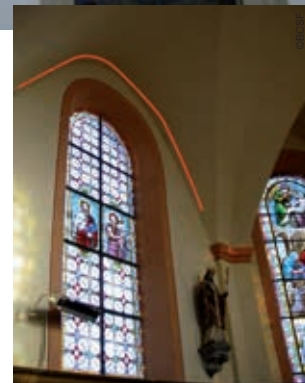
(photo 32) Destord Fissuration au raccordement des tympans avec la voûte
