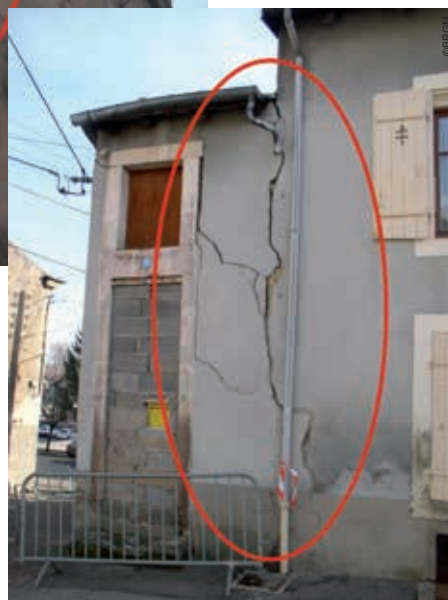
(photo 68) Baccarat (Dép. 54) Fissuration large sur mur extérieur
