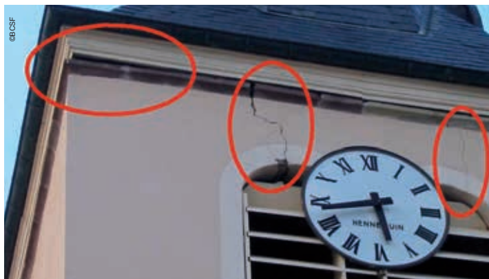
(photo 19) Sainte-Hélène (départ.88) Fissuration du clocher de l'église et effet de plateau sur la toiture.
