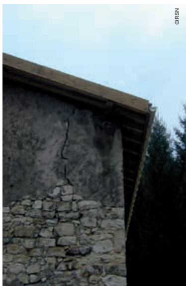
(photo 40) Frémifontaine (dép.88) Maison évacuée, exemple de fissure sur un coin
