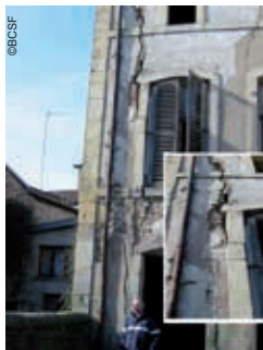
(photo 41) - Rambervillers (dépt. 88) - Elargissement d'une fissuration sur bâtiment en cours de démolition.
