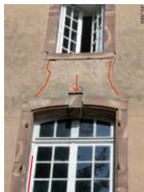
(photo 49) Façade sud, corps du bâtiment
