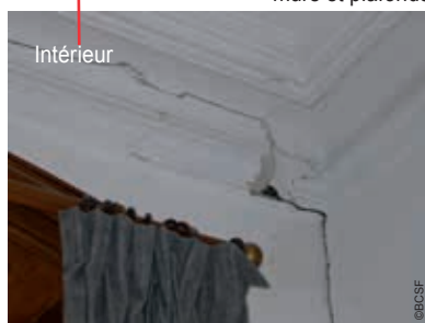
(photo 55) Fissuration large sur le remplissage de la voûte
