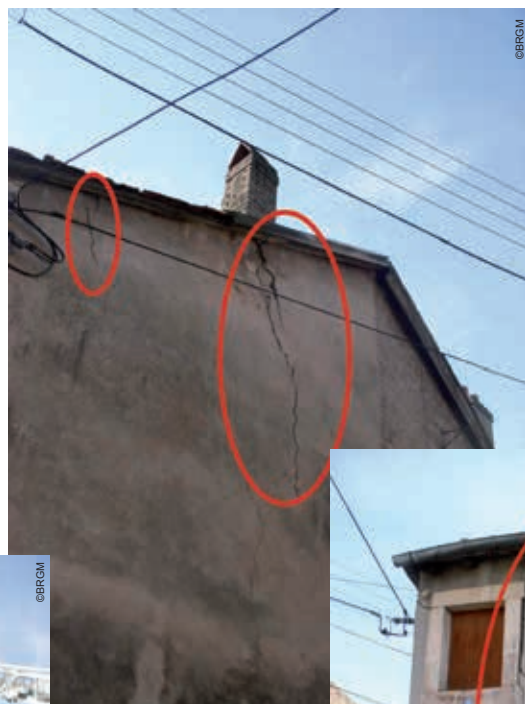
(photo 68) Baccarat (Dép. 54) Fissuration large sur mur extérieur
