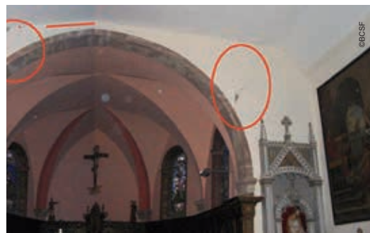
(photo 22) Sainte-Hélène Fissuration au niveau du toit de la nef et de l'arc principal.
