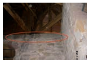
(photo 63) Chaînage du haut du clocher ayant maintenu la structure
