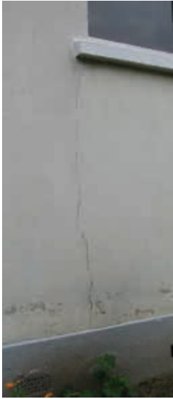
[fig. 74] - Fissure sur mur extérieur - façade ouest (Ecole Notre Dame du Vœu, Hennebont).
