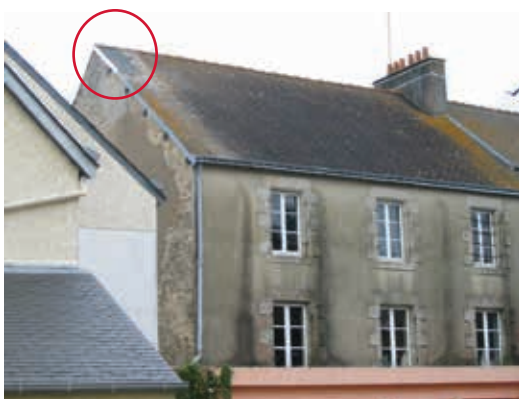
[fig. 76] - Localisation d'une cheminée ébranlée, démontée ici (Hennebont - Ecole Ntre.Dame du Vœu).
