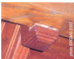
[fig. 55]-Pierrefitte-Nestalas, poutre en bois d'escalier désolidarisée de la charpente principale
