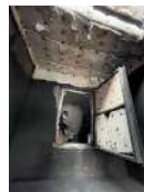
Photo 5 - Isolant dégradé
