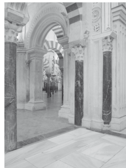
illustr. 11 – fusion entre colonne et pilier, lisible par contraste de couleur des matières
