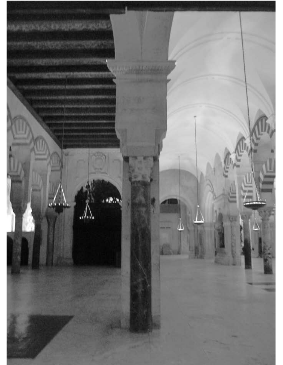
illustr. 4 - choix de restauration donnant à lire, de part et d'autre d'une arcade, le plafond sombre musulman (à gauche) et les fausses voûtes claires des chrétiens (à droite)
