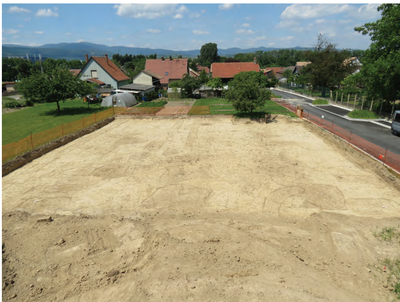
Fig. 7. Vue générale du terrain après le décapage (Cliché : A. Mauduit)
