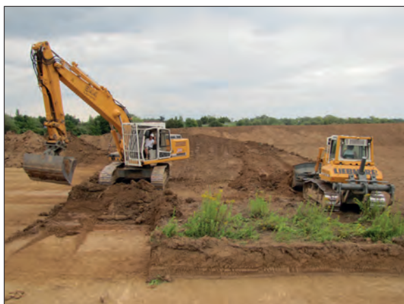
Fig. 20 - Cliché de l'opération de décapage et d'évacuation des déblais.
